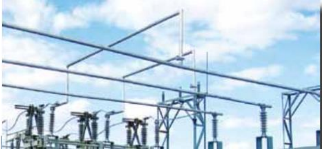
1.12-сурет – 110 кВ ашық тарату құрылғысының блоктары өзара қатты шиналаумен қосылуы
